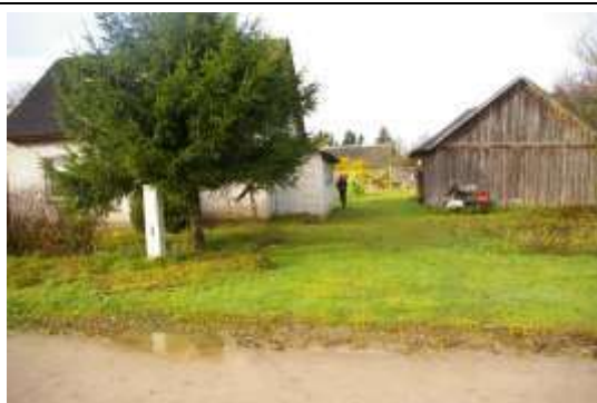
Kopskats uz vērtējamo Objektu no Dārza ielas puses
